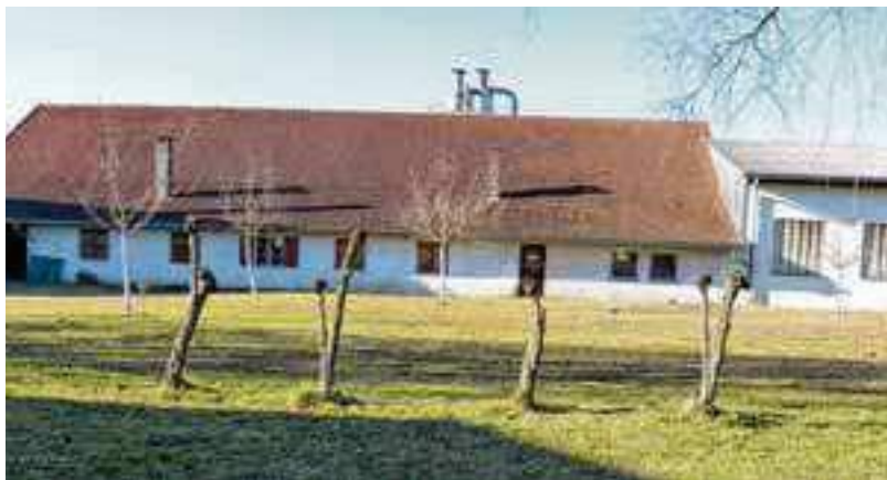
Dort, wo jetzt ein altes Sägewerk steht, wird das Süddeutsche Schützen-Zentrum in Illerbeuren errichtet.
