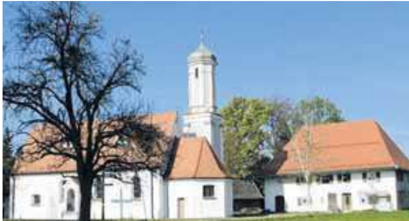
Das ehemalige Mesnerhaus (rechts) neben der Benninger Riedkapelle wird derzeit zu einem Informationszentrum umgebaut. Archivfoto: Walzl-Jensen
