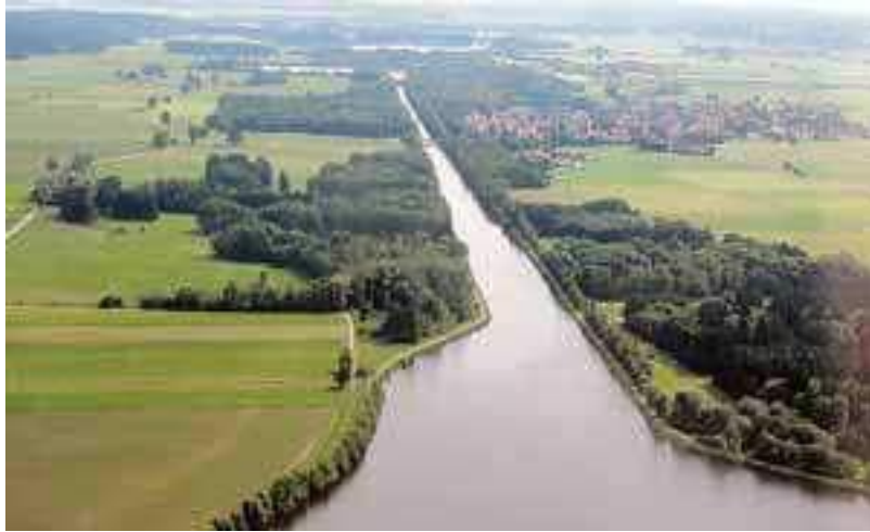
Die Wertach bei Bad Wörishofen. Ein Radweg mit neuen Attraktionen soll den Fluss vom Ursprung bis zur Mündung begleiten.
