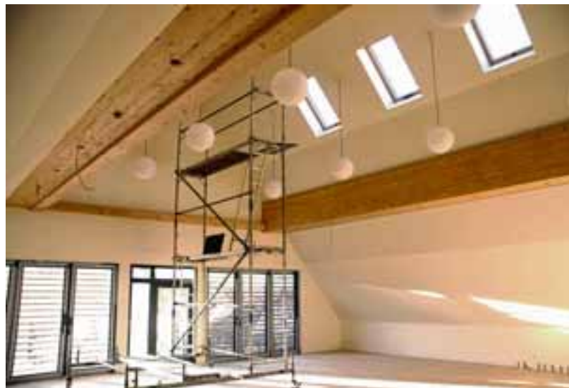
Der letzte Schliff: Derzeit wird noch die Außentreppe an das neue Erkheimer Gemeinschaftshaus angebracht (Bild oben). Unten: Im neuen Pfarrsaal werden bereits die Lampen angebracht.
