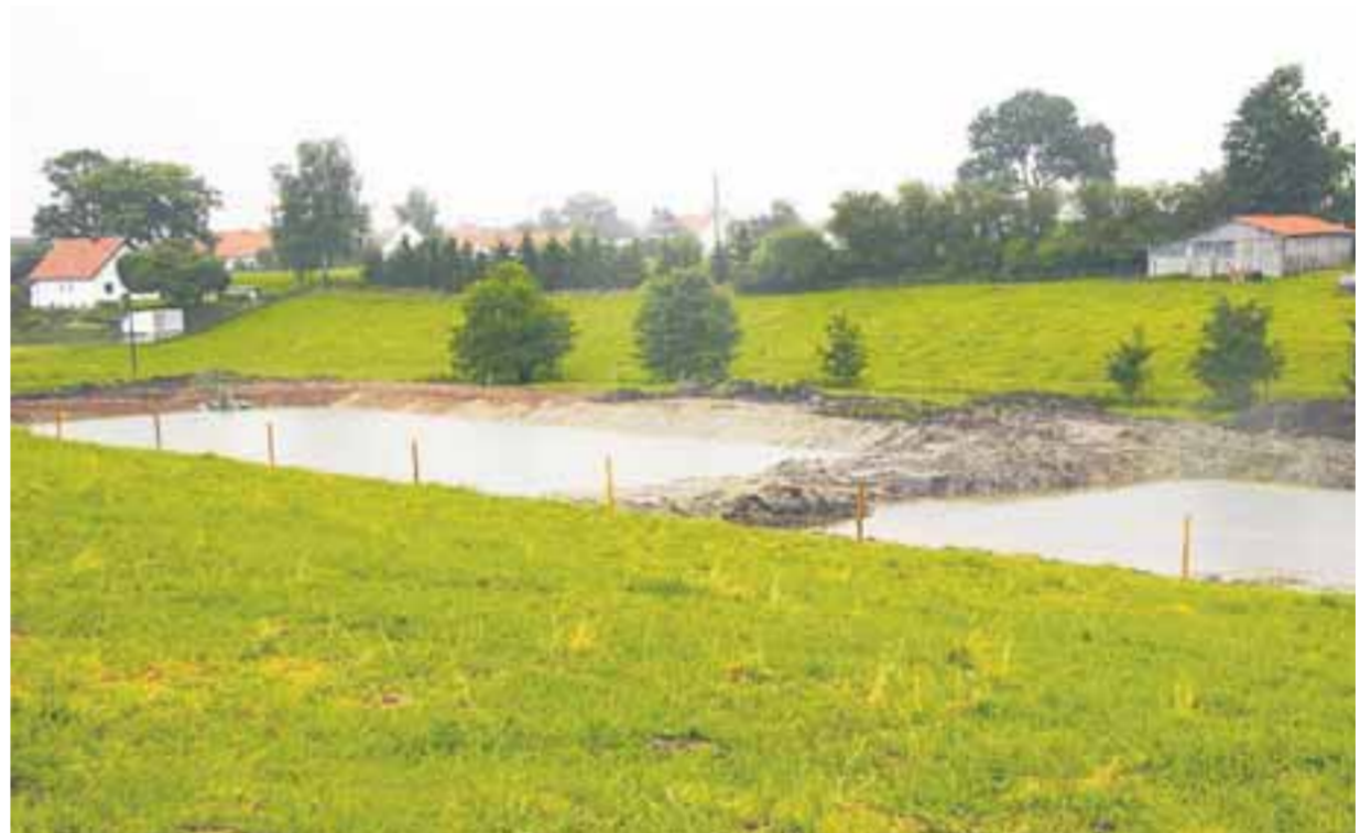
Der sich im Bau befindliche Dorfweiher (links) soll laut Bürgermeister Paul Nagler ein „verbindendes Element“ zwischen Holzgünz und Schwaighausen werden. Der rechte Weiher ist ein Reinigungsweiher, der mit Pflanzen bestückt wird. Fotos: Simone Schaupp
